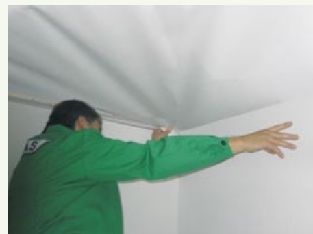
Instalace podhledu vyrobeného na míru
