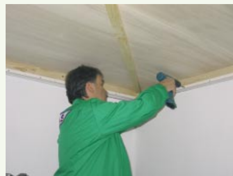
Upevnění profilů na zeď
